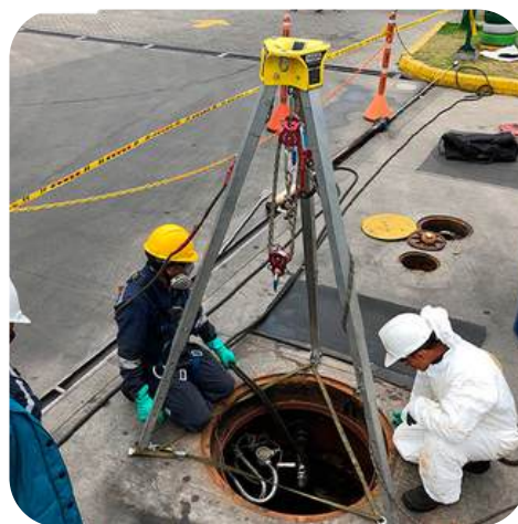
LIMPIEZA INTERNA DE TANQUES
